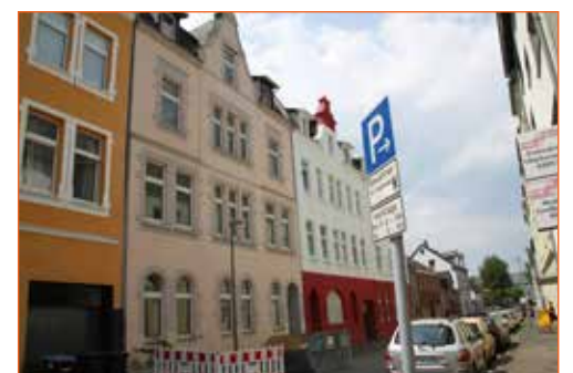
In einigen Monaten wird die Baustelle dem neuen Stadtteilkinderzimmer weichen
